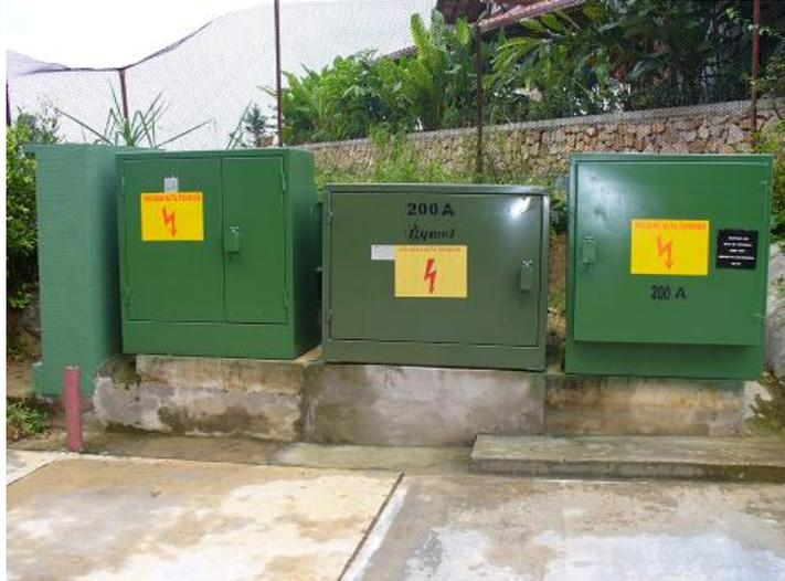
Figura 1.4 Subestación tipo jardín (pad mounted)
