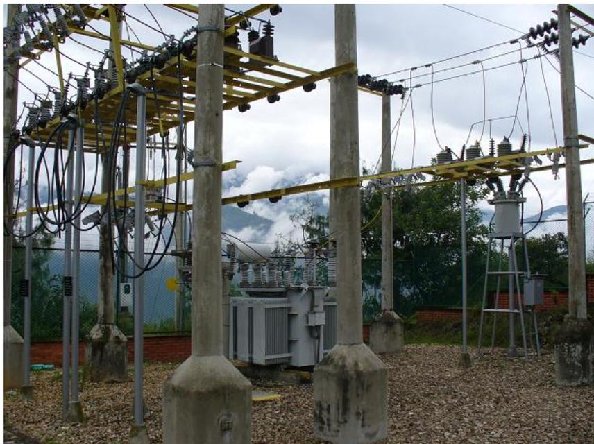
**Figura 1.2 Subestación de pedestal**
